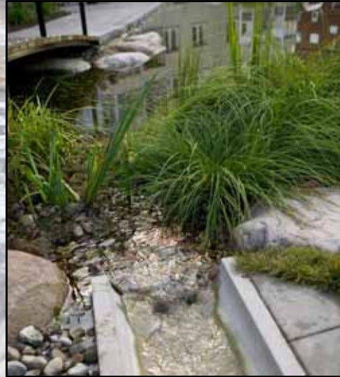
Stormwater drainage canal Photo Courtesy of: Malmo Kommunala Bostadsbolag (MKB)
